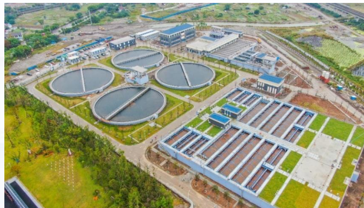
净水处理、供水
